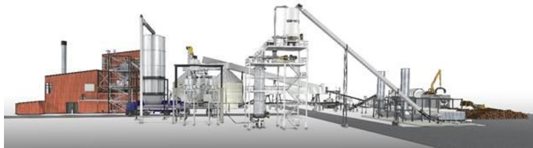
Valmetin mustaa pellettiä tuottava laitos CHP –laitoksen yhteydessä
